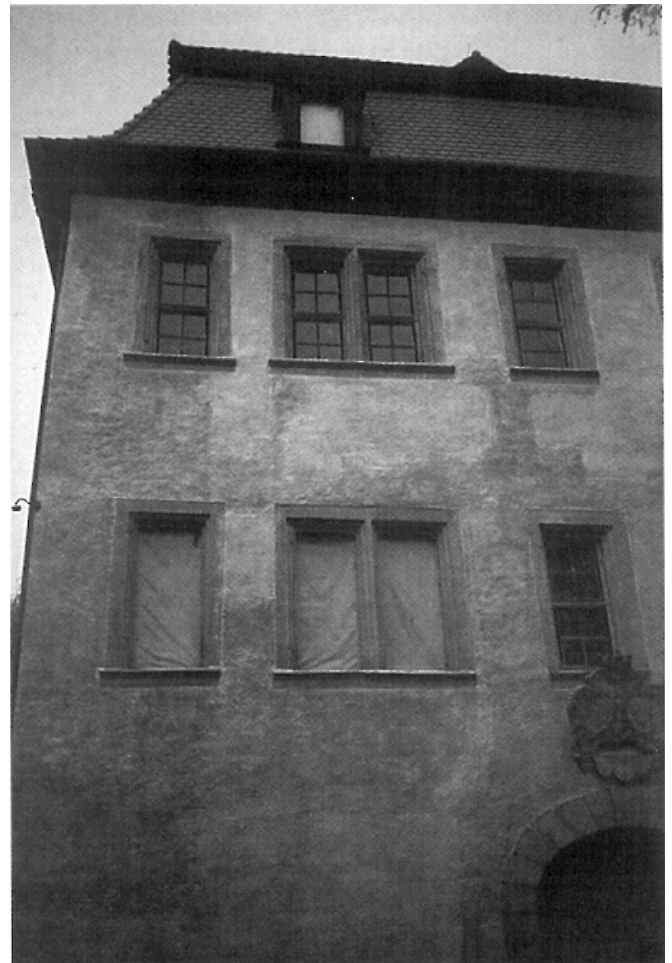
Schloßfassade: Fehlstellenergänzung mit gestupftem Putz
